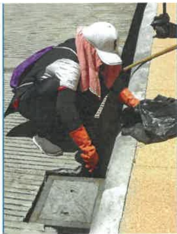
ภาพถ่ายที่ 2.2-13 การขุดลอกท่อระบายน้ำรอบโครงการ
